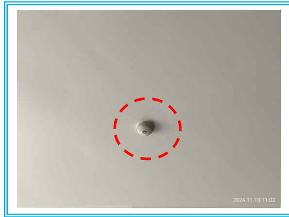
รูปที่ 2.6-6 เครื่องตรวจจับความร้อน
