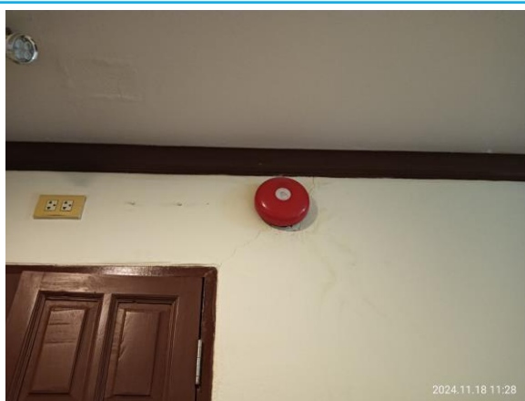
รูปที่ 3-55 อุปกรณ์แจ้งเหตุเพลิงไหม้ด้วยเสียง
